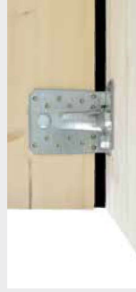
Gemessener Aufbau – mit Winkelverbinder und Schrauben
