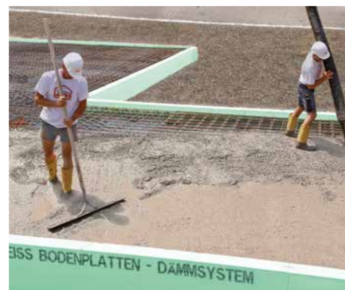
Alle WEISS-SWD-Keller (sickerwasserdicht) und DWD-Keller (druckwasserdicht) werden nach höchsten Qualitätsstandards errichtet.
