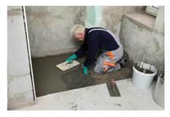
PCI Novoment M1 plus ist ein Schnellestrich-Fertigmörtel und daher eine wirtschaftliche und besonders praktische Lösung für den Einbau von kleineren Flächen und Estrich-Teilflächen, die schnell genutzt werden müssen
