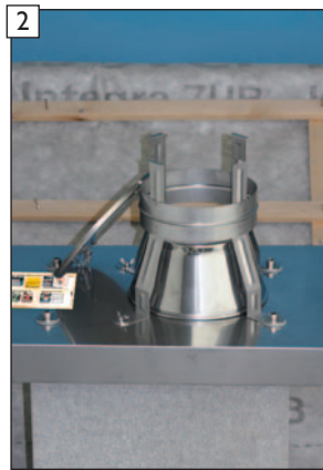
2 Der Revisionsdeckel ist mit einer Drahtschlinge, als „Absturzsicherung“, verbunden. Die Drahtschlaufensicherung mind. einmal im Jahr überprüfen und ggf. erneuern.
