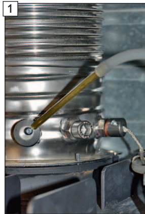
1 Ansicht vor Reinigungsbeginn mit bereits entfernter Frontverkleidung am KINGFIRE GRANDE SC.
