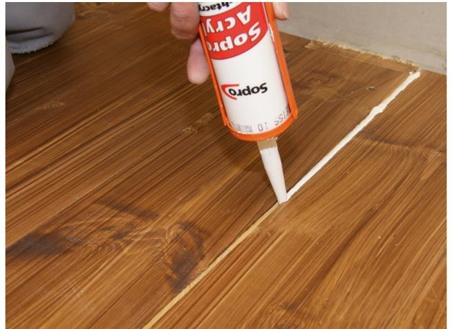
Damit die selbstverlaufende Spachtelmasse für die Ausgleichsarbeiten nicht in die Fugen zwischen den Holzdielen einläuft, sind die Fugen mit Sopro Dichtacryl zu schließen.
