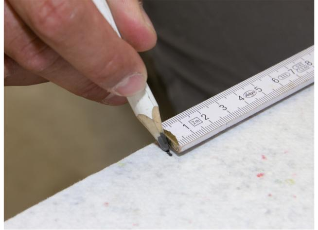
Anriss zum maßgenauen Schneiden einer Sopro FliesenDämmPlatte.
