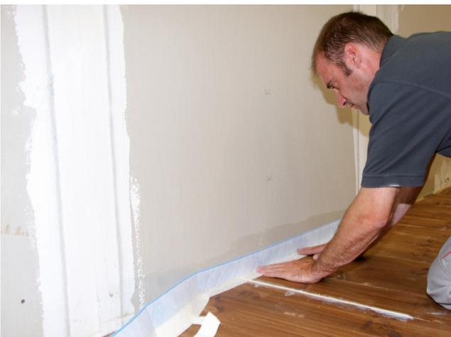
Zu allen aufgehenden Bauteilen (Wände) sind Randdämmstreifen, z. B. Sopro RandDämmstreifen, anzuordnen.
