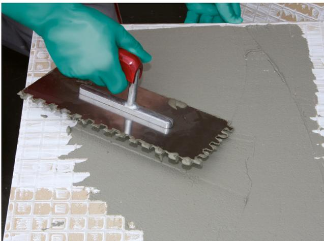
Die Anwendung des Buttering-Floating Verfahrens ist von Format und Rückseitenbeschaffenheit der Fliese abhängig und dient der weitgehend vollflächigen Verklebung des Belages.
