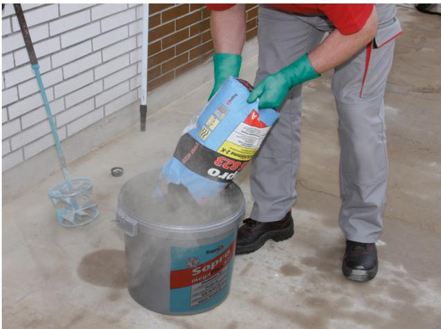
Hinzugeben der Trockenkomponente der Sopro TurboDichtSchlämme 2-K.
