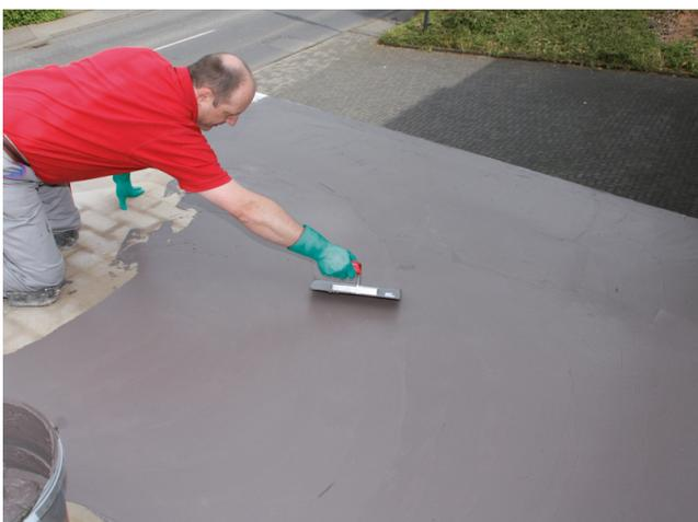
Glätten der Sopro TurboDichtSchlämme 2-K mittels Glättkelle.
